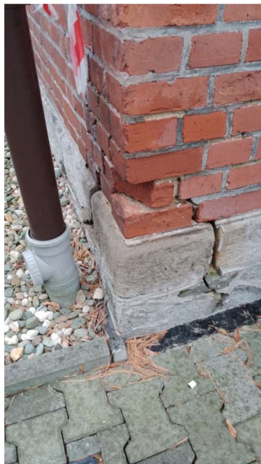
Zdj. 1-3 – uszkodzone narożniki i widoczne ubytki zaprawy w ścianach zewnętrznych piwnicy
