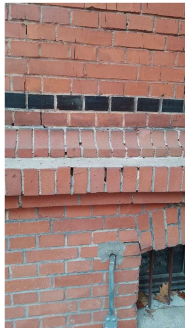
Zdj. 1-3 – uszkodzone narożniki i widoczne ubytki zaprawy w ścianach zewnętrznych piwnicy
