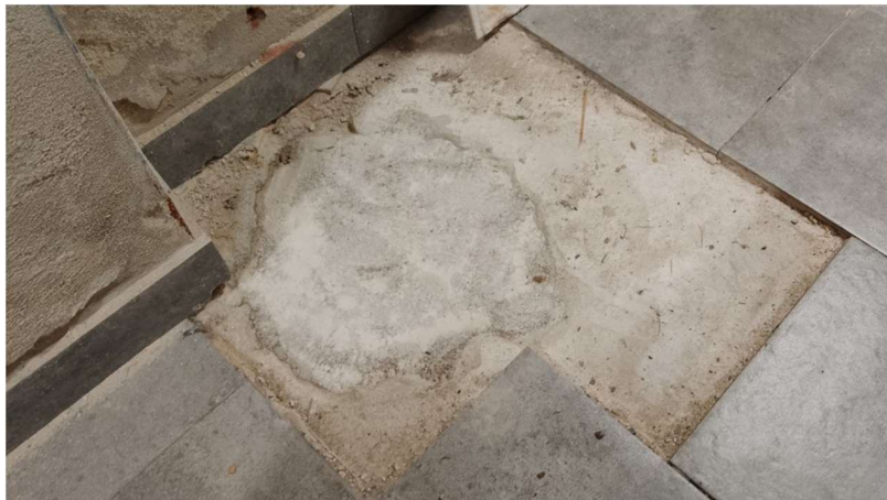
Zdj. 8 – widok na skorodowany klej
