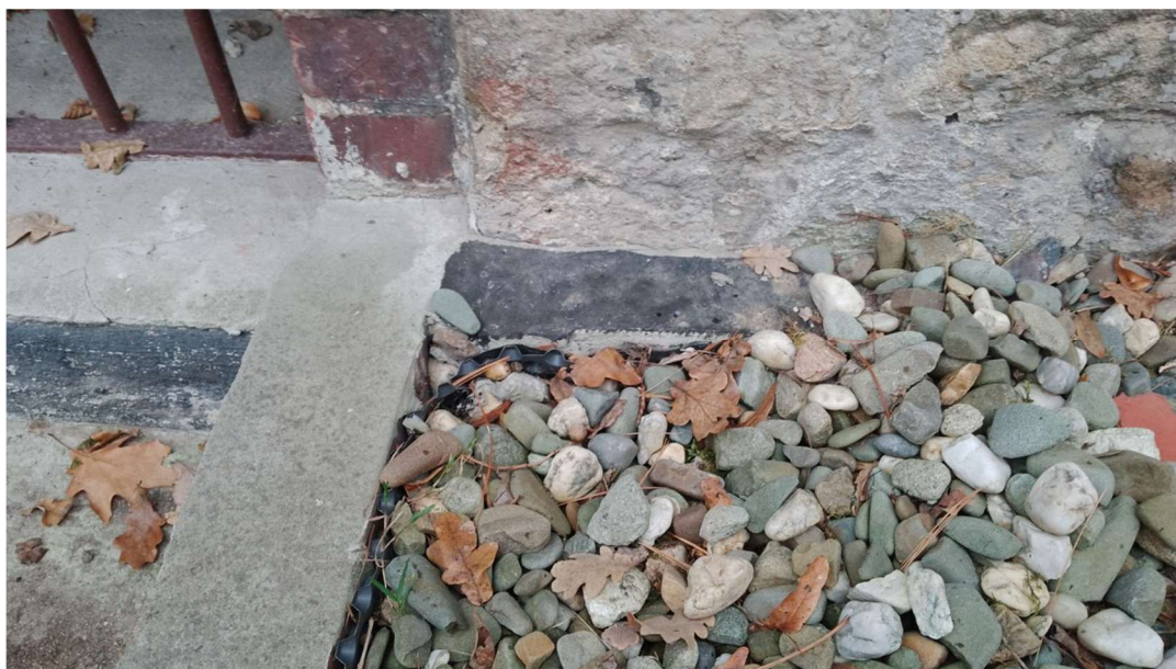
Zdj. 7 – widok na izolację pionową wychodzącą spod warstwy zasypki żwirowej
